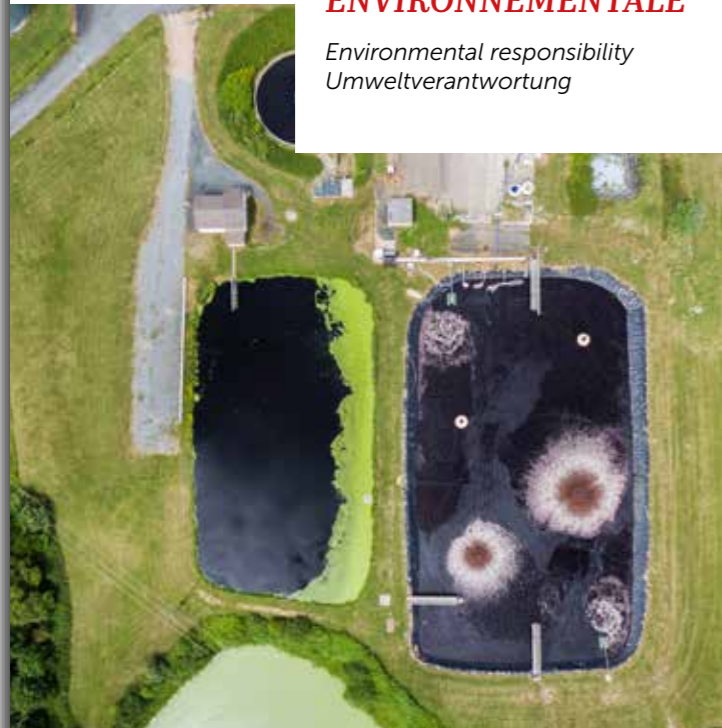
Station d'épuration sur notre site On-site water treatment plant Kläranlage an unserem Standort
